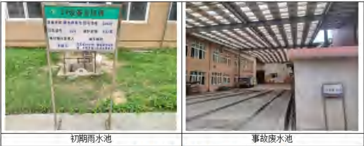
图 4.3-1 现有项目初期雨水池和事故废水池现场照片
